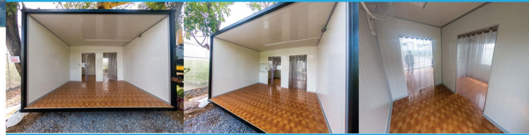
รูปผนังสำเร็จรูปด้านในโครงการ
