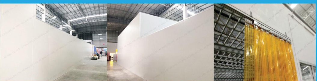
รูปผนังงานเสร็จรูปเมื่อเสร็จงาน
