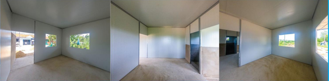
รูปผนังสำเร็จรูปด้านนอกห้องเย็น
