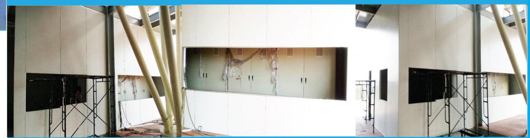
รูปผนังสำเร็จรูปเจาะเพื่อติดตั้งหน้าต่าง
