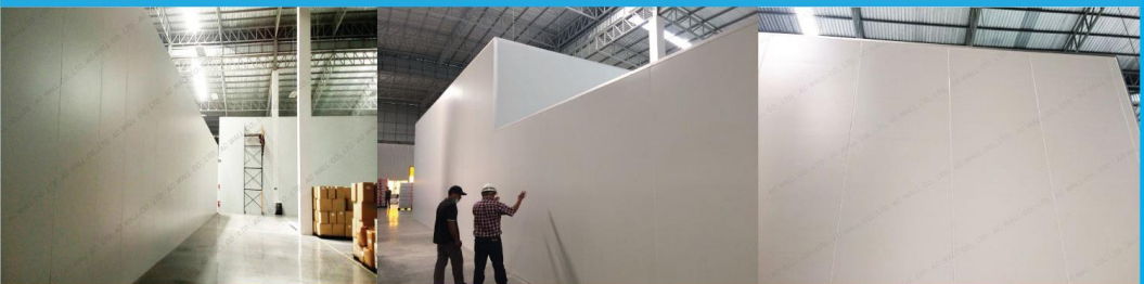
รูปผนังสำเร็จรูปจากมุมสูง
