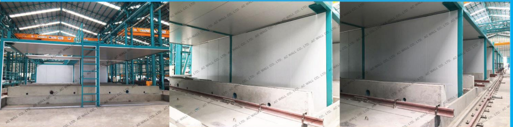
รูปผนังสำเร็จรูปจากด้านในตัวห้อง
