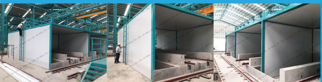
รูปผนังสำเร็จรูปเมื่อติดตั้งเสร็จสิ้น
