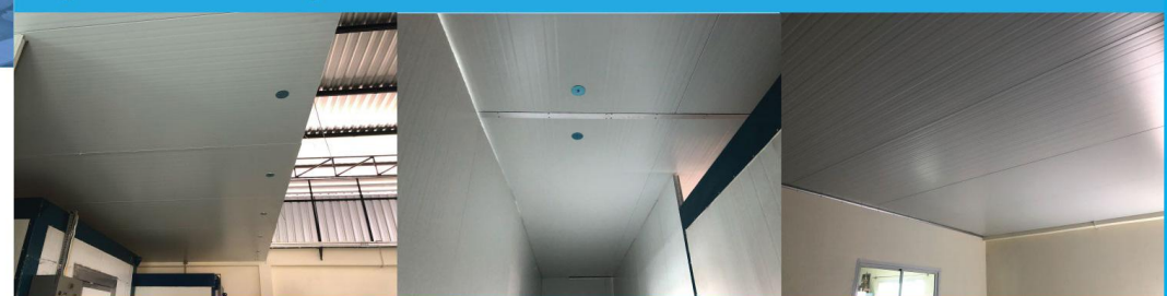
รูปเพดาน แผ่นฉนวนสำเร็จรูป ภายนอกโครงการ
