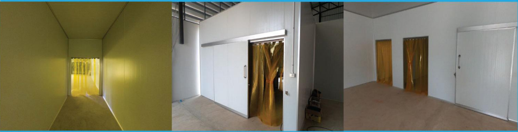
รูปผนังสำเร็จรูปเจาะเพื่อติดตั้งประตูและม่านเหลือง PVC
