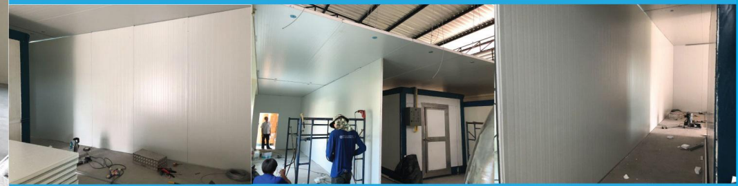
รูปผนัง แผ่นฉนวนสำเร็จรูป ภายในโครงการ
