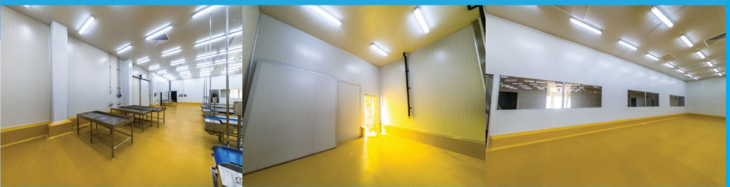
รูปผนังสำเร็จรูปด้านในโรงงาน
