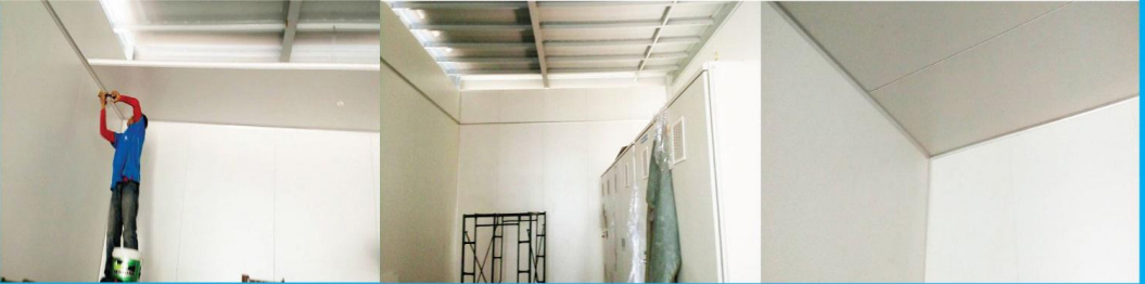
รูปการทำงานขึ้นผนังสำเร็จรูป
