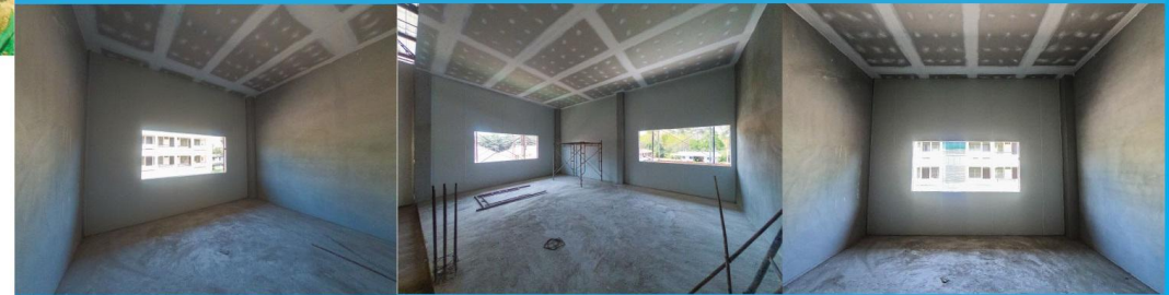
รูปภายในห้องเจาะผนังเพื่อทำหน้าต่าง
