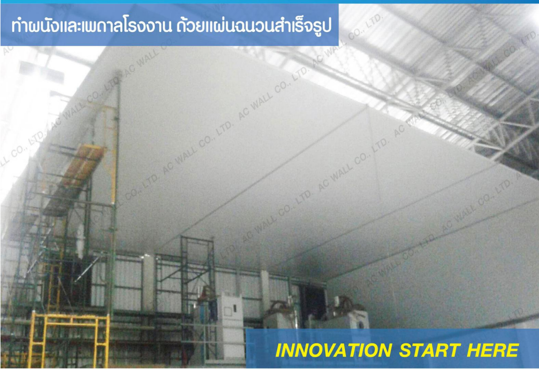
รูปการทำงานขึ้นผนังสำเร็จรูป
