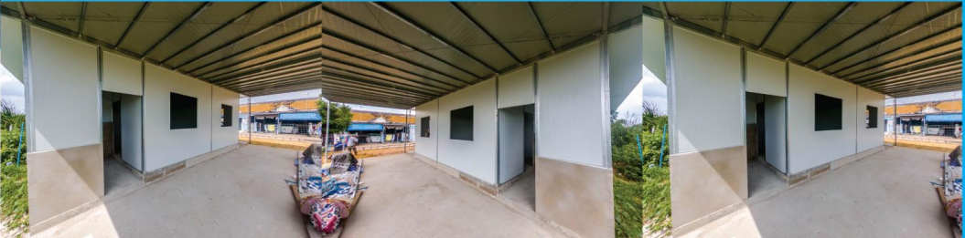
รูปผนังสำเร็จรูปด้านในโรงงาน
